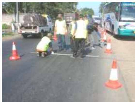
Lampiran 16 Foto Pemeriksaan Kerataan Permukaan Jalan
