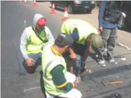
Lampiran 19 Foto Pemasangan Pad Sensor Beban
