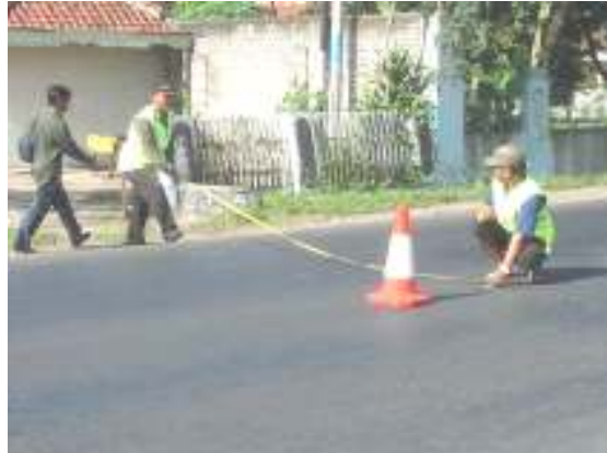
Foto Pemasangan Kabel Loop
