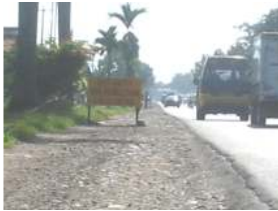
Lampiran 15 Foto Pemasangan Rambu Lalu Lintas
