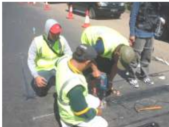
Foto Pemasangan Pad Sensor Beban
