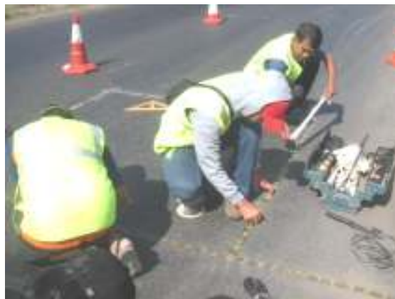
Foto Pemasangan Pad Sensor Beban
