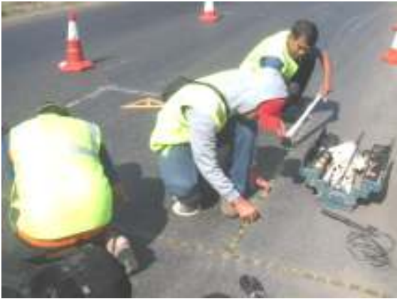
Lampiran 18 Foto Pemasangan Kabel Loop
