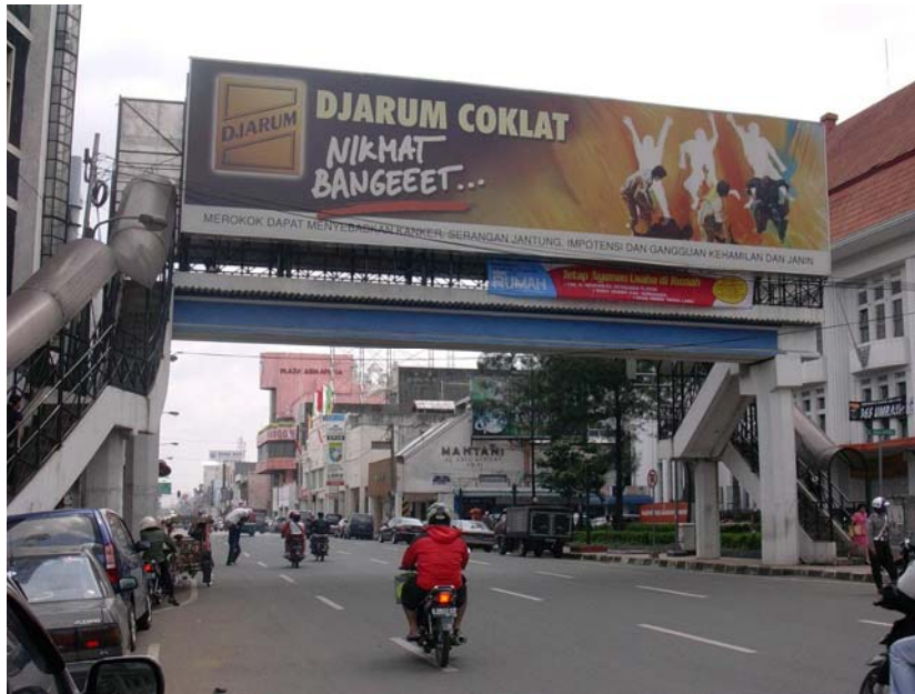
Jembatan Penyeberangan Tampak Barat
