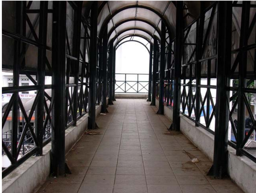
Kondisi Jembatan Penyeberangan di Jalan Asia Afrika
