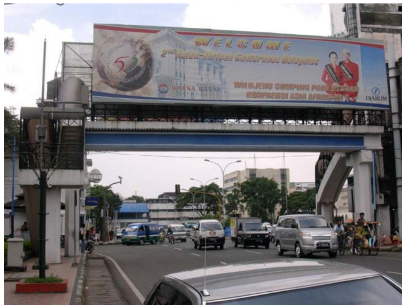
Jembatan Penyeberangan Tampak Timur
