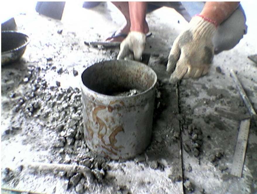
Lampiran 34. Situasi akan menimbang berat beton segar
