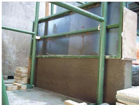
Gambar 5. Tahap setelah pengecoran lapisan pertama.
