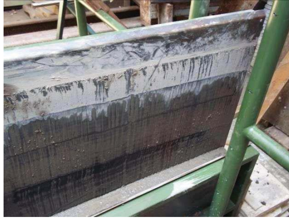
Gambar 6. Kondisi setelah ereksi.
