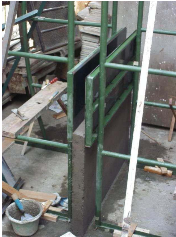
Gambar 7. Tampak samping setelah ereksi pelat tahap ketiga.
