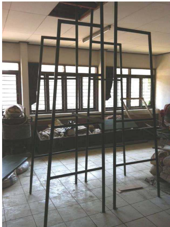
(b). Struktur rangka bekisting terpasang.
