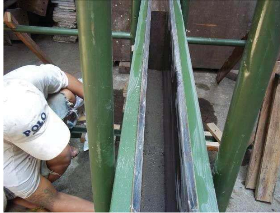
Gambar 3. Penyetelan bekisting sebelum proses cor.
