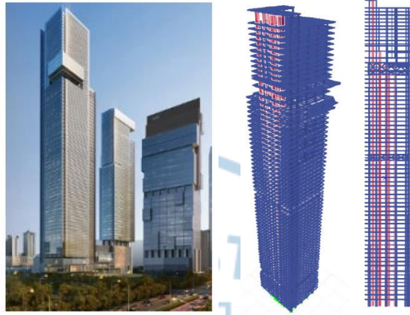
Gambar 1.2 Gedung Thamrin Nine di Jakarta Sumber: Meinhardt, 2015
