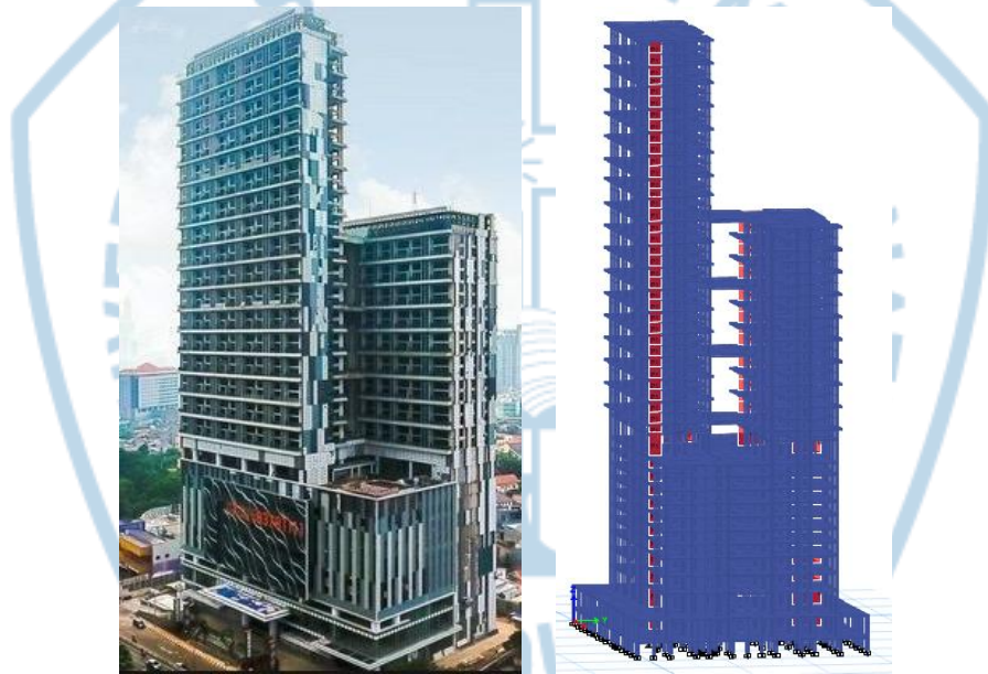
Gambar 1.4 Bangunan Tinggi di Jakarta serta Pemodelan Sumber: sewakantorjakarta.asia , diakses tanggal 5 Agustus 2018
