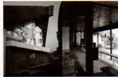
Gambar 10 & 11 Overstek dan teritis yang panjang untuk mengantisipasi curah hujan yang tinggi (sumber gambar : koleksi pribadi)
