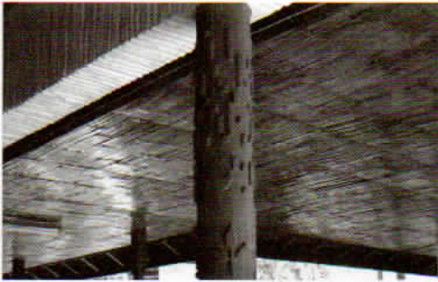
Gambar 12 Plafond dari bahan bambu dan artikulasi permukaan balok yang terbentuk dari cetakan bambu (sumber gambar : koleksi pribadi)
