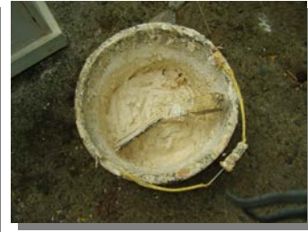
Proses Pendempulan Awal (menutupi pori-pori )
