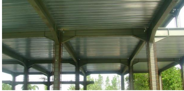
Gambar 1.1 Balok non Prismatis
