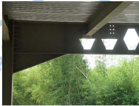
Gambar 1.2 Voute pada Struktur Bangunan Baja
