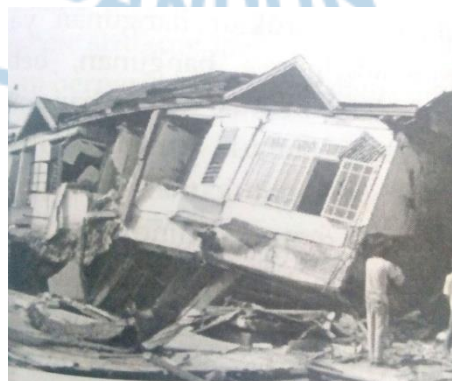
Gambar 1.3 Kerusakan Kolom Rumah Tinggal Akibat Gempa Sumatera Barat
