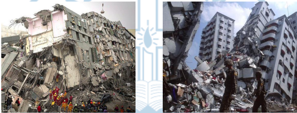
Gambar 1.1 Keruntuhan Bangunan Tingkat Tinggi Akibat Gempa Sumber: http://images.hngn.com/data/images/full/196962/weiguan-jinlong-building-collapse.png , https://i.ytimg.com/vi/8cqQJCmLWQ/maxresdefault.jpg , diakses 25 Agustus 2017
