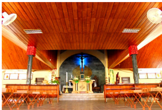
Gambar 5. Plafond Bangunan Gereja yang Tidak Terlalu Tinggi Sumber: laman facebook Gereja Santa Maria Fatima, Sragen, Jawa Tengah
