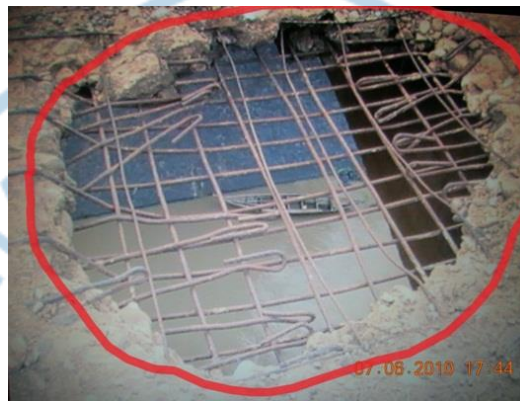
Gambar 1.2 Kerusakan Pelat Sumber: Andriani, 2011
