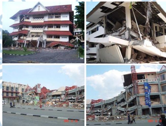
Gambar 1.1 Kerusakan Struktur Bangunan Sumber: BMKG, 2014
