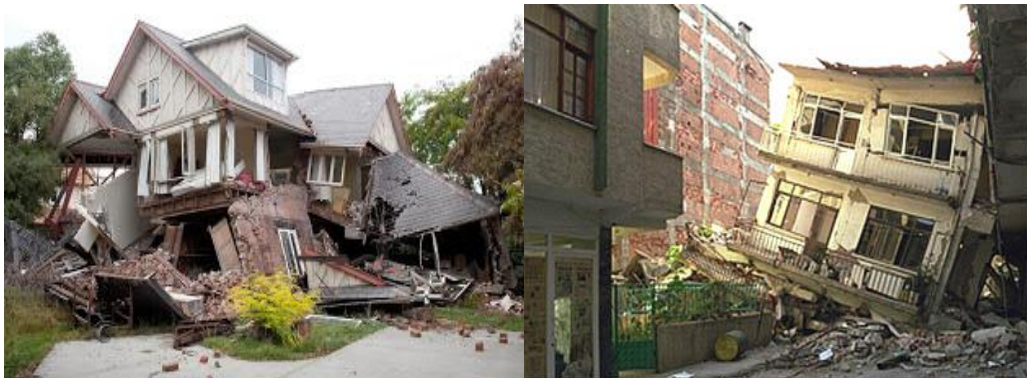
Gambar 1.1 Keruntuhan Bangunan Akibat Gempa Bumi
