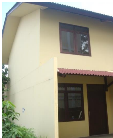
Gambar 1.6 Rumah Kayu LVL 1 (kompleks PU di Jl. Suling, Turangga, Bandung)
